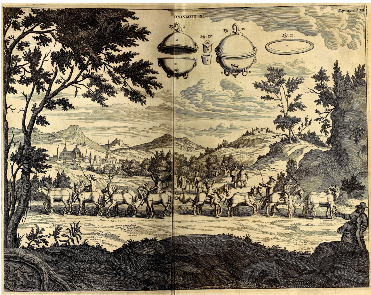
L'esperimento degli Emisferi di Magdeburgo rappresentato nella tavola fra p. 104 e p. 105 di «Ottonis de Guericke. Experimenta nova (ut vacantur) Magdeburgica de vacuo spatio», 1672 (immagine ricavata dalla versione software dell'opera presente su "archive.org").
